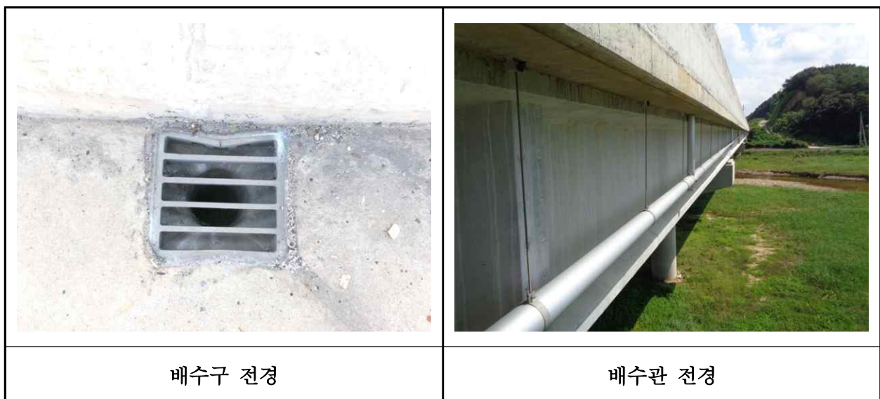
【사진 17.3.44】 배수시설 전경
