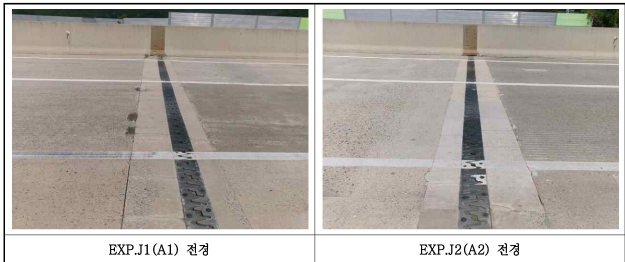
【사진 17.3.39】 신축이음장치 전경
