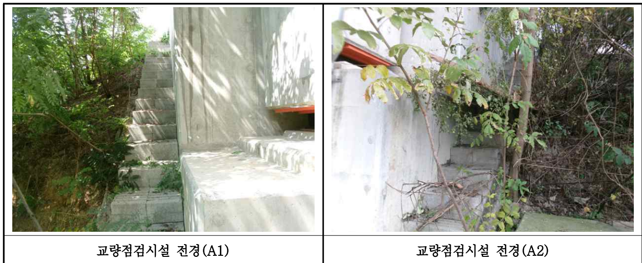
【사진 17.3.48】 교량 점검시설 전경
