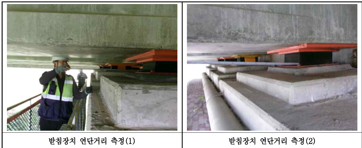
【사진 17.3.37】 교량받침장치 연단거리측정
