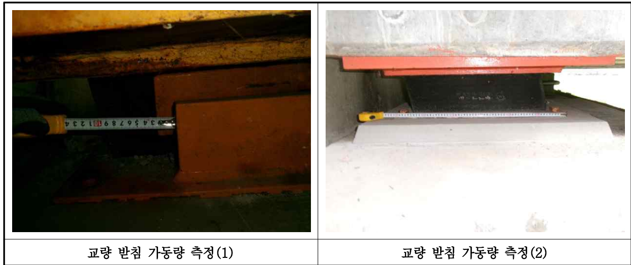
【사진 17.3.38】 교량받침 이동량 측정
