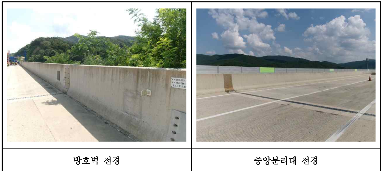
【사진 17.3.46】 방호벽 및 중앙분리대 전경
