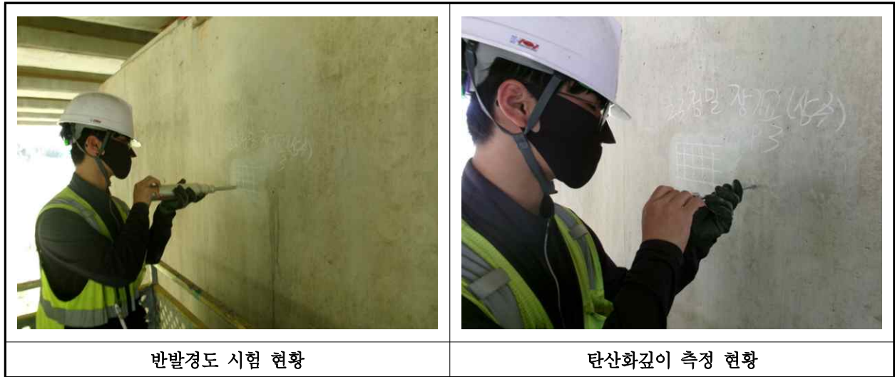
【사진 17.4.1】 콘크리트 내구성조사 현황
